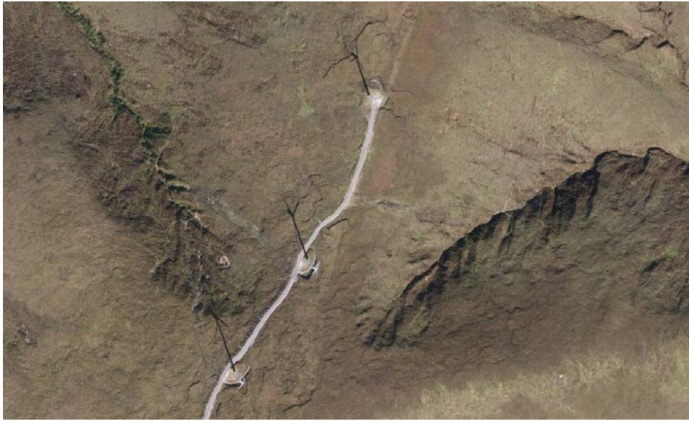
Aspecto del sistema de turberas de cobertura de la Siera del Xistral en el lugar de Pasada do Lamoso (O Valadouro, Lugo). El vial que se muestra fue abierto durante la construcción del parque eólico, ocasionando una destrucción muy significativa de los hábitats turbosos.
