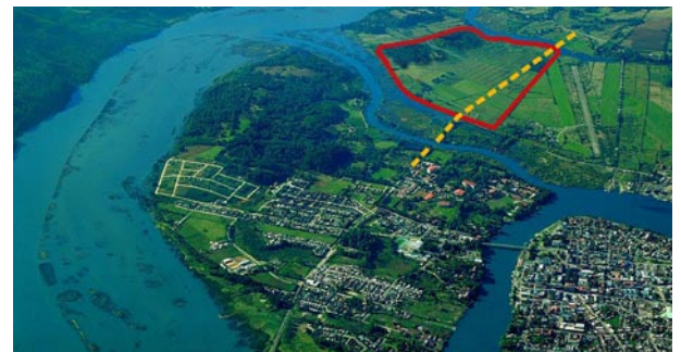
Proyecto urbanización Fundo Cau-Cau
