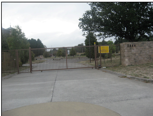
Foto 29: Acceso a Condominio Los Silos. Torobayo.
