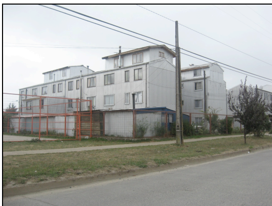
Foto 9: Viviendas sociales multifamiliares sector René Schneider (Teniente Merino 3)
