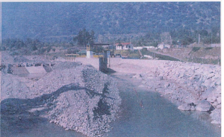
▲Obras de bocatoma en la primera sección del Río Maipo Izquierda: canal San Carlos para uso agrícola, Derecha: entrada al canal abastecedor del agua potable manejado por EMOS
