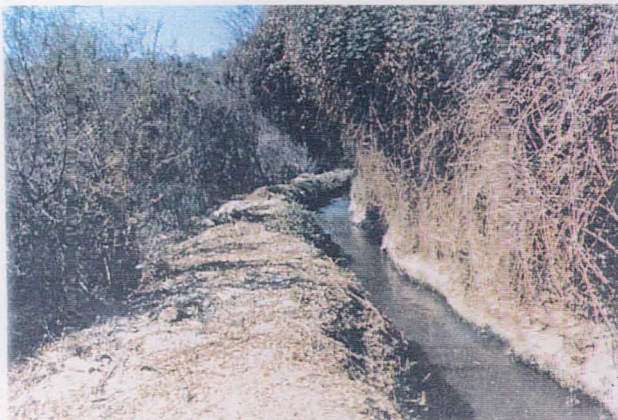
▲ Parte sur del canal principal en la zona Mallarauco - Las Carrera
