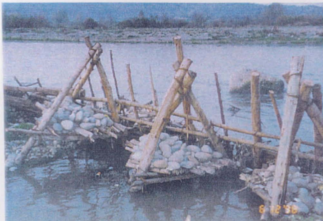
▲Obra de bocatoma tradicional (aguas abajo del Río Mapocho)
