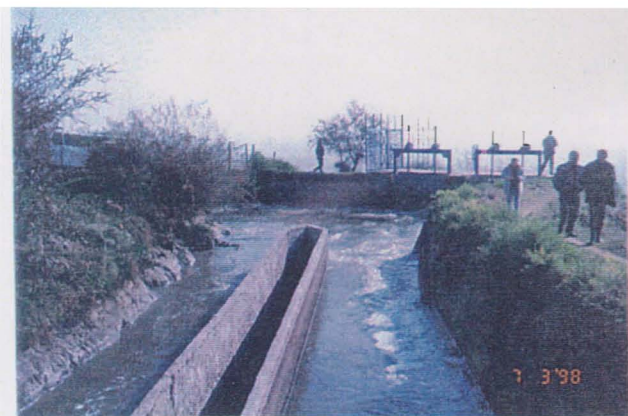
▲Obras de bocatoma en aguas medias del Río Mapocho (Canal Mallarauco)
